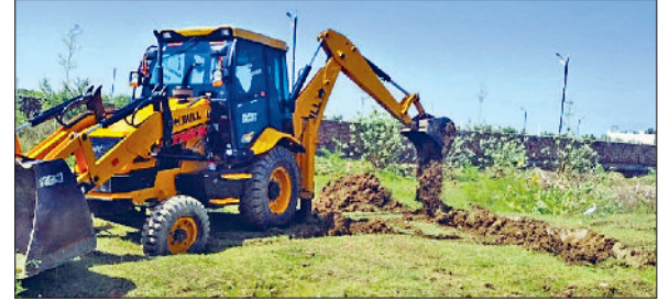
हांसी। अवैध रूप से बनाई जा रही कालोनी के निर्माण गिराती जेसीबी।
